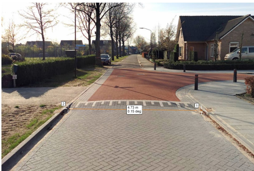
Figuur 9 Huidig wegprofiel Christinastraat (bron: Cyclomedia, 2022)
